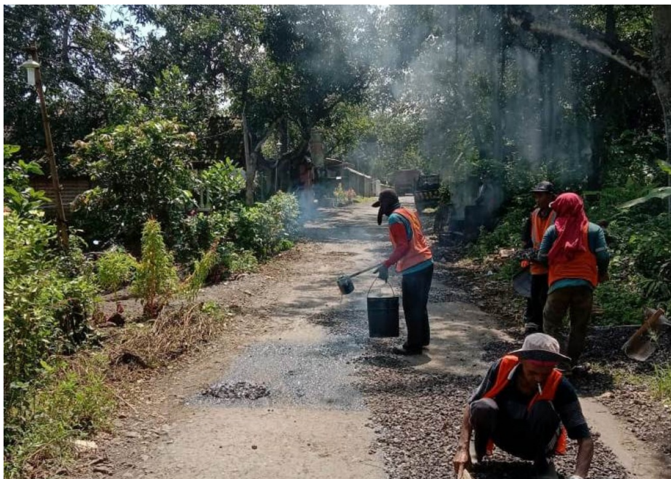
Pekerja mulai memperbaiki sejumlah ruas jalan yang mengalami kerusakan.
